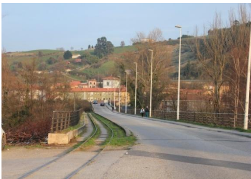
FOTO- 17. (El "Puente de los Italianos").
