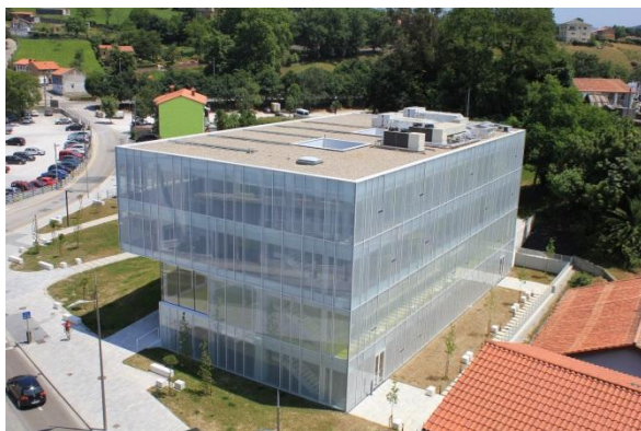
FOTO- 25. (Más de 500 metros cuadrados, para poder instalar paneles solares en este edificio público de nueva construcción).
